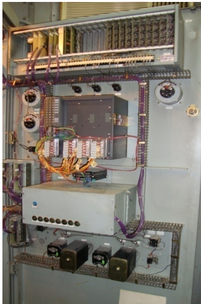
Fig13: Thermocouple Module & Annunciator
